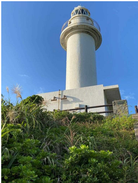
石垣御神埼灯台
